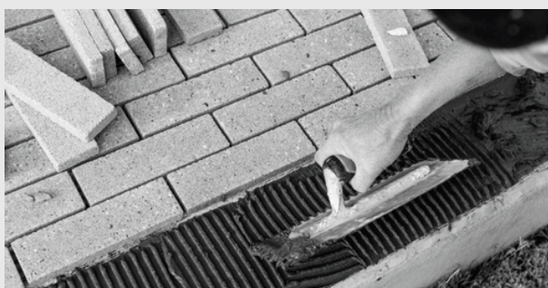
Breng mortel aan op de ondergrond, strijk met de getande spatel.
