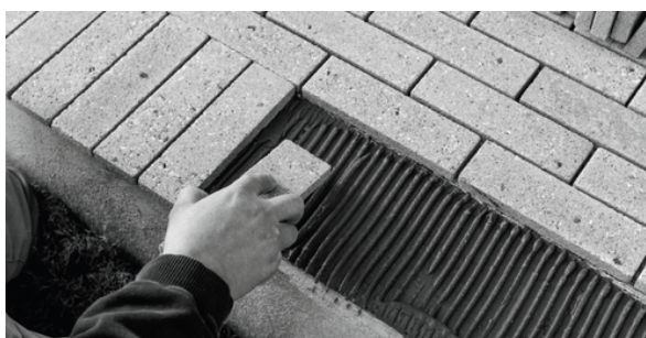
Druk de beboterde tegel stevig in het mortelbed.
